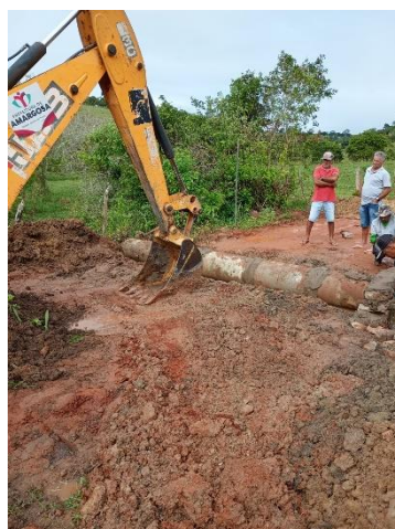
Foto 16 – Passagem de manilhas – Tabuleiro dos Coelho
