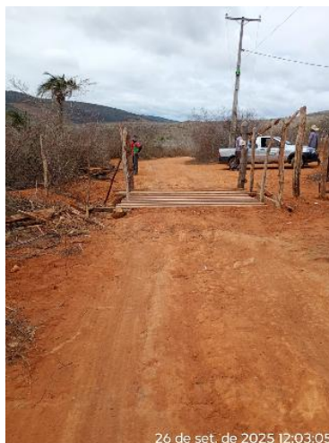
Foto 17 – Construção de Mata Burro Passagem do Lajedo– 26/09/2025.
