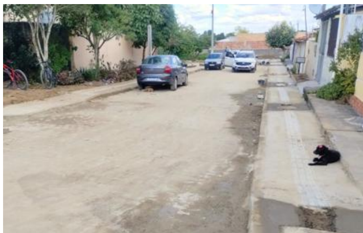
Foto13 - Pavimentação e drenagem – Loteamento São Rafael 31/10/2025.
