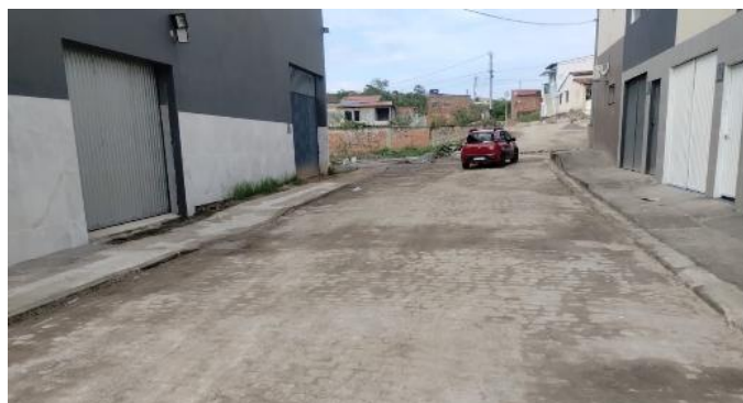
Foto 12 - Pavimentação em paralelepípedo no Loteamento Tropical Center 26/11/2025.
