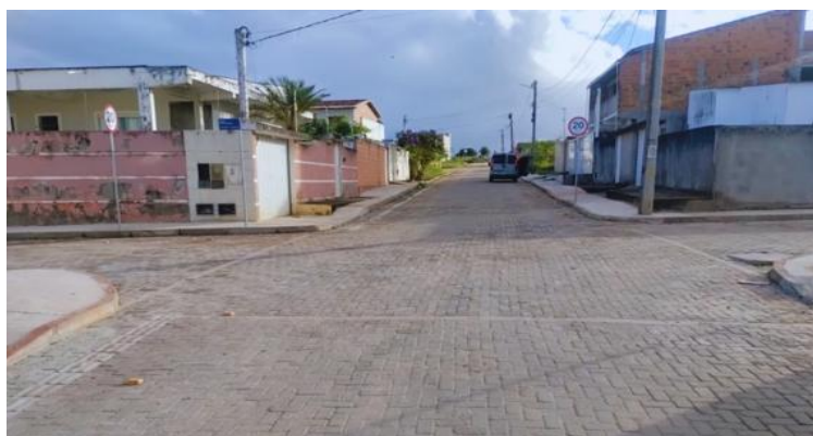
Foto 7 - Pavimentação de ruas com piso intertravado e Drenagem – Rodão 30/07/2025.
