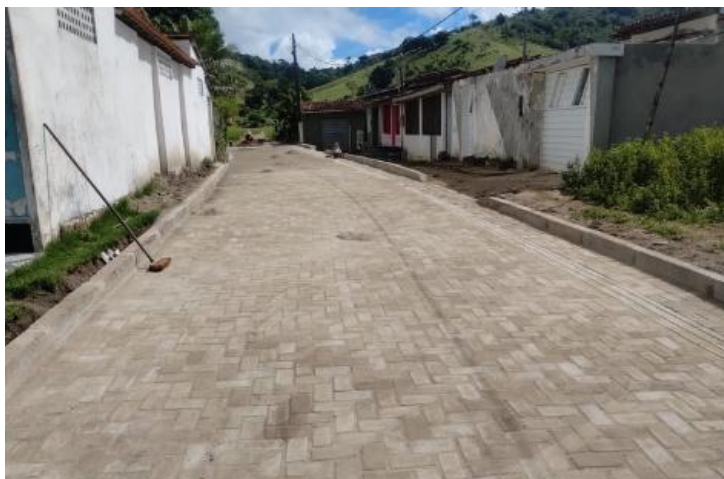
Foto – 14 Pavimentação de ruas da comunidade de Corta-Mão 19/12/2025.
