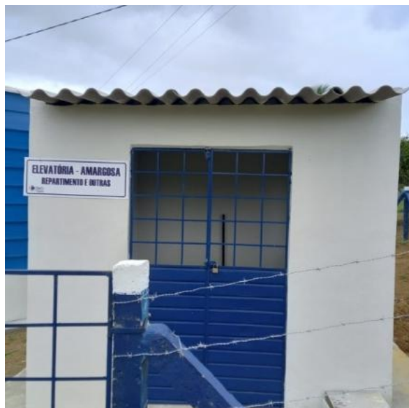
Foto 11 - Implantação de rede de abastecimento de água no Repartimento 16/10/2025.
